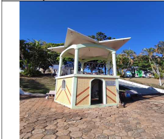
Foto 9: Coreto Estrela Matutina visto de frente, destacando detalhes da estrutura. Alex Alves Pereira, 27 jun. 2025.
