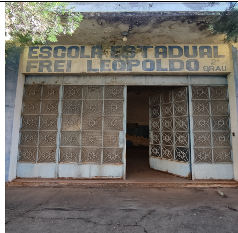
Foto 4: Entrada principal da antiga E.E.Frei Leopoldo. Alex Alves Pereira, 27 jun. 2025.
