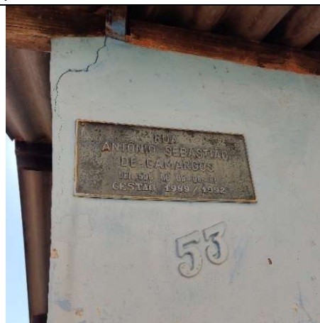
Foto 6: Placa de identificação de vias fixada na fachada de uma edificação. Alex Alves Pereira, 27 jun. 2025.
