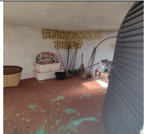
Foto 10: Depósito de apoio localizado abaixo do Coreto Estrela Matutina, utilizado para armazenamento de materiais de manutenção. Alex Alves Pereira, 27 jun. 2025.
